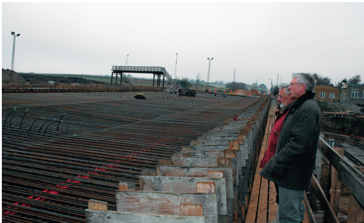
Niels Lauritzen og Egon Christensen, formand for Støttefonden, følger støbearbejdet af broen, der skal føre Randersvej over den ny motorvej mod Skødstrup og Grenå.
