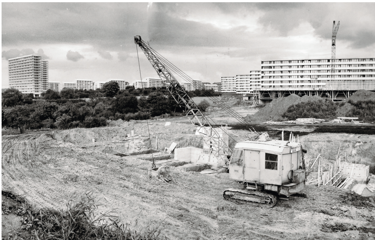
Der bygges højt på Langenæs. Det er nu montagebyggeri, og de færdige betonelementer er støbt på fabrik. Den høje tårnkran var blevet en nødvendighed og et symbol på det moderne byggeri.
