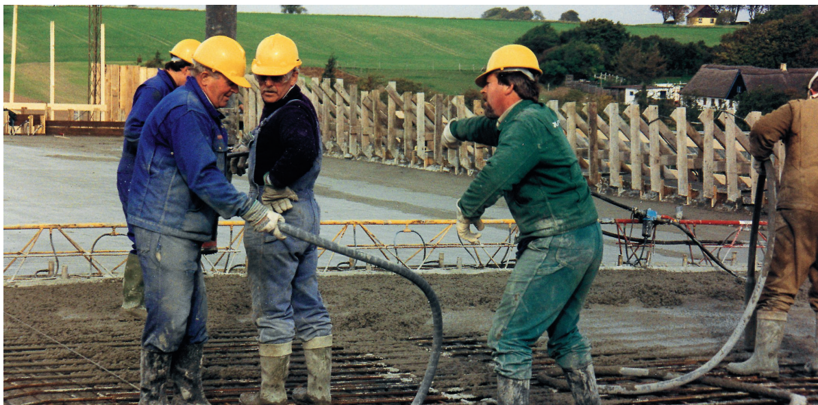
Siden starten i 1932 har arbejdet med beton været det bærende for virksomheden. Her er betonfolk i færd med at støbe endnu et brodæk.
