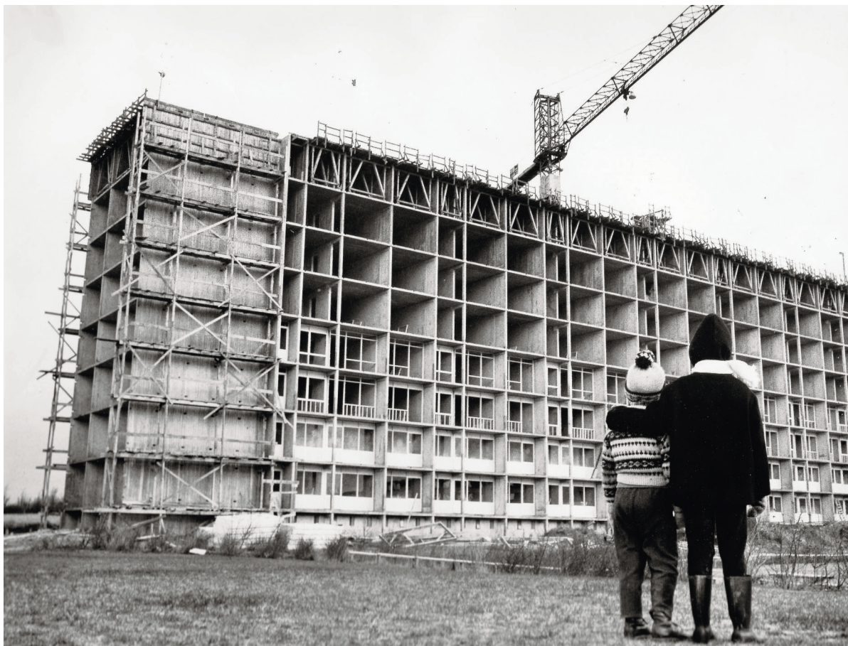
Montagebyggeri blev større og større. Knapthed på jord betød at der blev bygget i højden. Der blev bygget med betonelementer, der betød at lejlighederne fik et ensartet præg.
