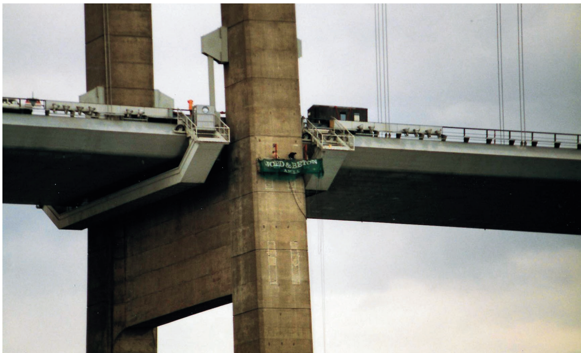
JORTON har også haft fornøjelsen af at få overdraget store reparationsopgaver på landets broer. Her er et arbejdssjak – højt til vejs – i færd med at reparere brodækket på motorvejsbroen over Lillebælt.
