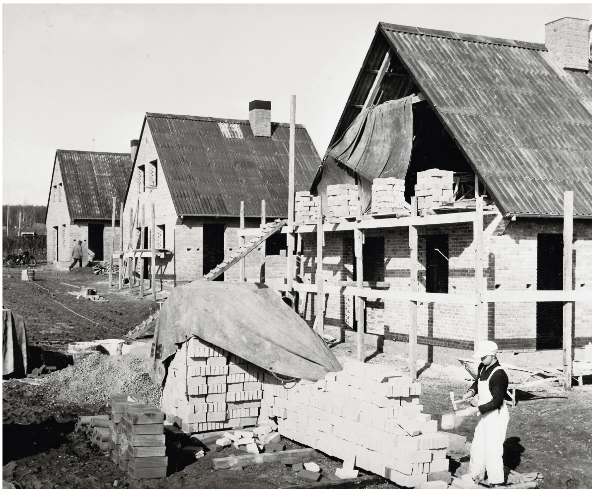
I marts 1957 kunne Boligforeningen Ringgården i Lystrup holde rejsegilde på 5 enfamiliehuse
