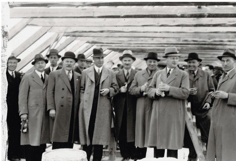
Der er noget særligt festligt over et rejsegilde. Arkitekt, bygherre og håndværkere mødes for festligt at markere at byggeriet er »under tag«. I midten af billedet ses forretningsfører Anders Jensen fra Hustømmerne, som senere indgik i Jord & Betonkoncernen. Billedet er fra 1938.
