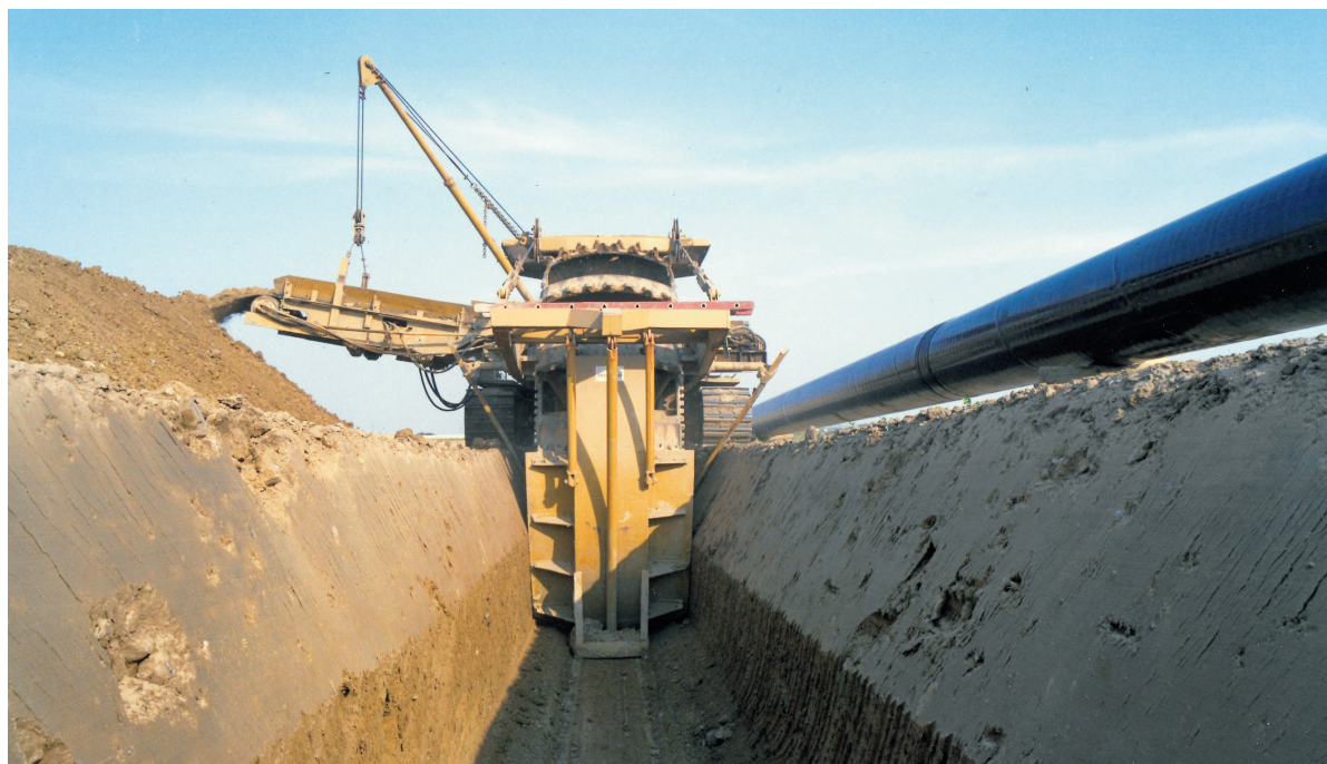
Der lægges gasledninger med tidens mest moderne materiel.
