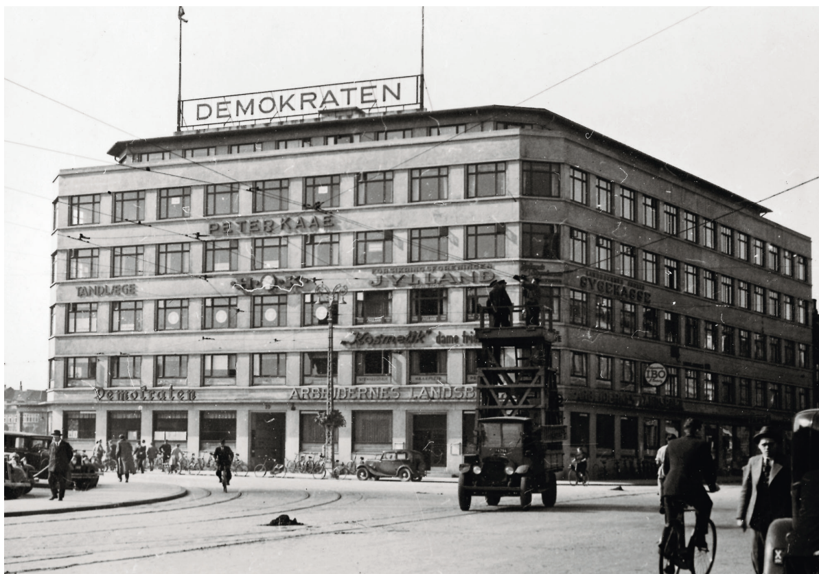
Demokratens store bladhus på Rådhuspladsen i Århus viste offentligheden, hvad den nye kooperative jord- og betonforretning kunne magte. Det var moderne byggeri, ikke i mursten som de omgivende bygninger, men støbt i beton. Billedet er fra efteråret 1937. Forrest i billedet bliver sporvognenes ledninger efterset.
