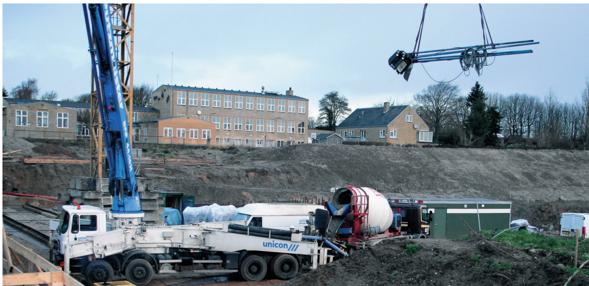
Det skal gå hurtigt, når der skal støbes et brodæk. Alt skal foregå i en glidende proces.
