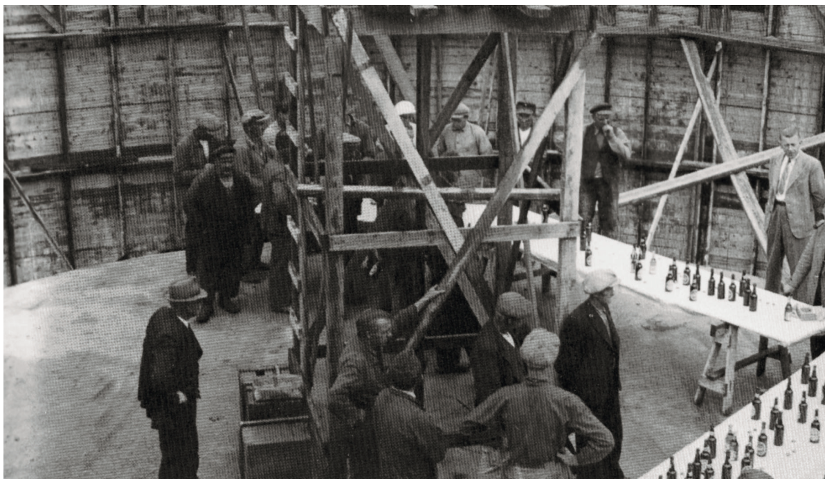
Rejsegilder har altid været opfattet som et festligt afbræk i dagligdagen. Her er det i en gasbeholder i Viby, bygningsarbejderne markerer at man er nået »halvvejs«. Aage Sørensen ses yderst til højre.
