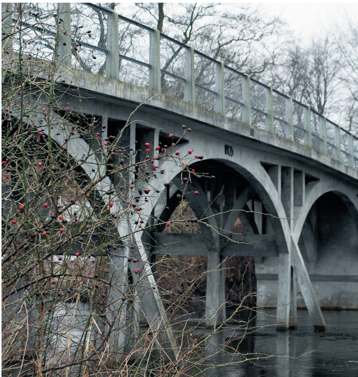
Amtmand hoppes bro over Gudenaåen ved Langå er landets ældste betonbro, fra 1905. JORTON forestod en renovering. Det var et krav, at de renoverede områder tydeligt afveg fra "originalen".
